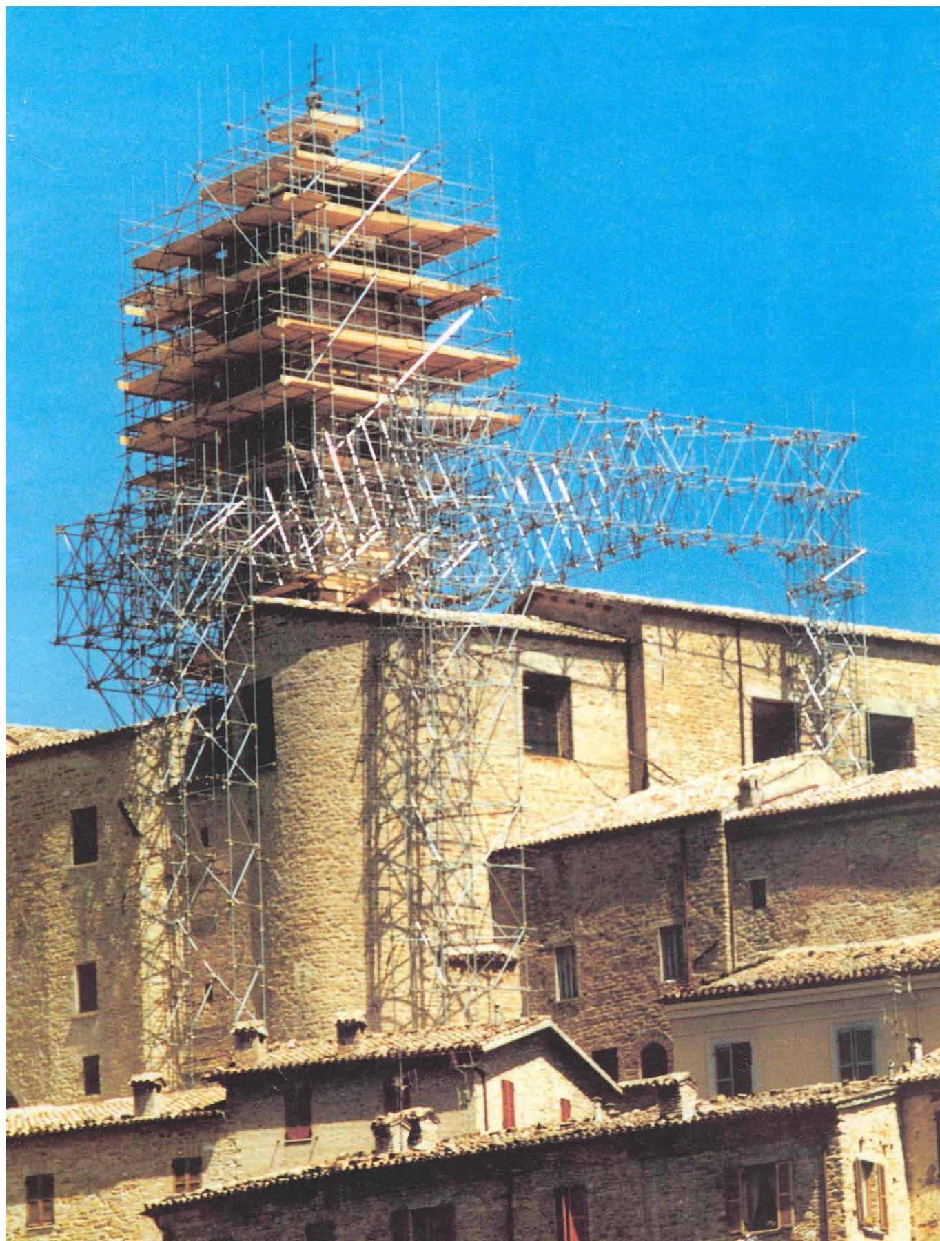
Torre della Chiesa di Santa Lucia durante i lavori
