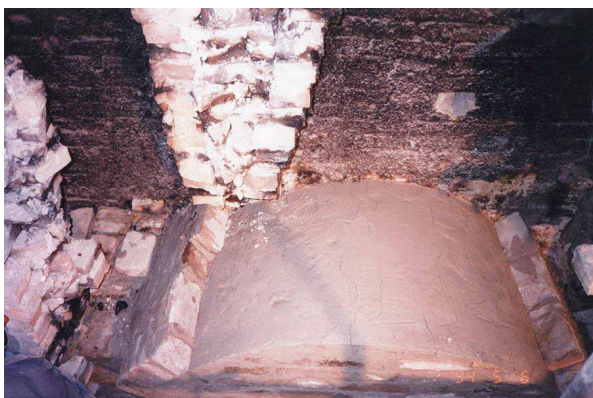
A sx particolare di ricostruzione della volta - A dx particolare della volta ricostruita
