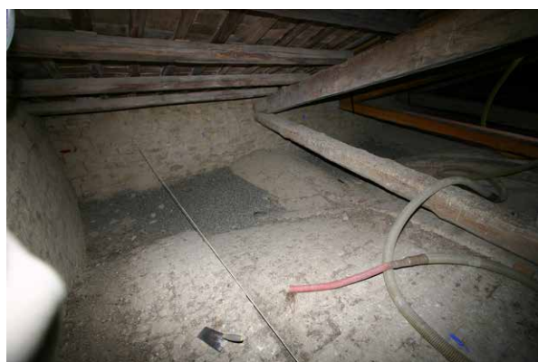
A sx particolare dell'estradosso da consolidare - A dx particolare dell'estradosso con la rete metallica come rinforzo
