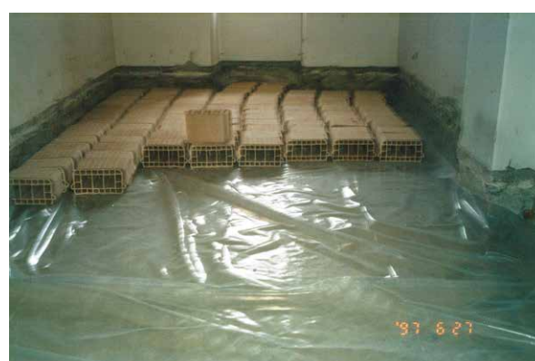
A sx demolizione del pavimento per eseguire il drenaggio - A dx posa di telo di nylon e tavelloni per il drenaggio
