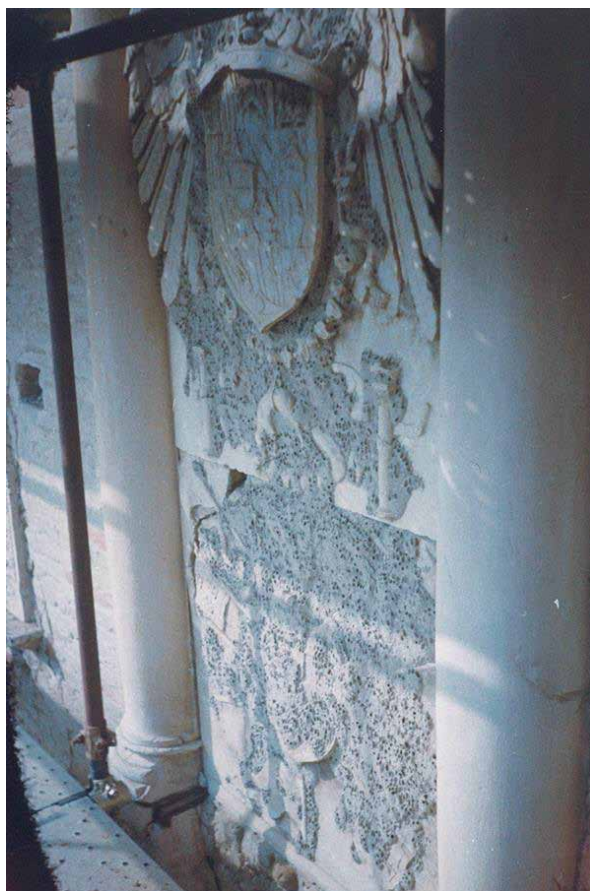
A sx Torre deteriorata prima del restauro - A dx particolare del degrado della facciata
