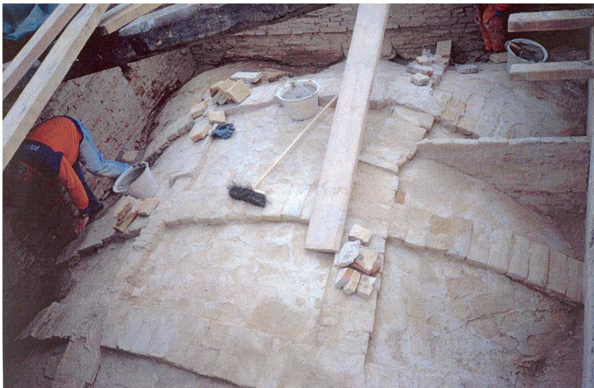
Restauro volte - 2° fase lavorativa: ripristino con l'integrazione dei mattoni mancanti e pulizia finale
