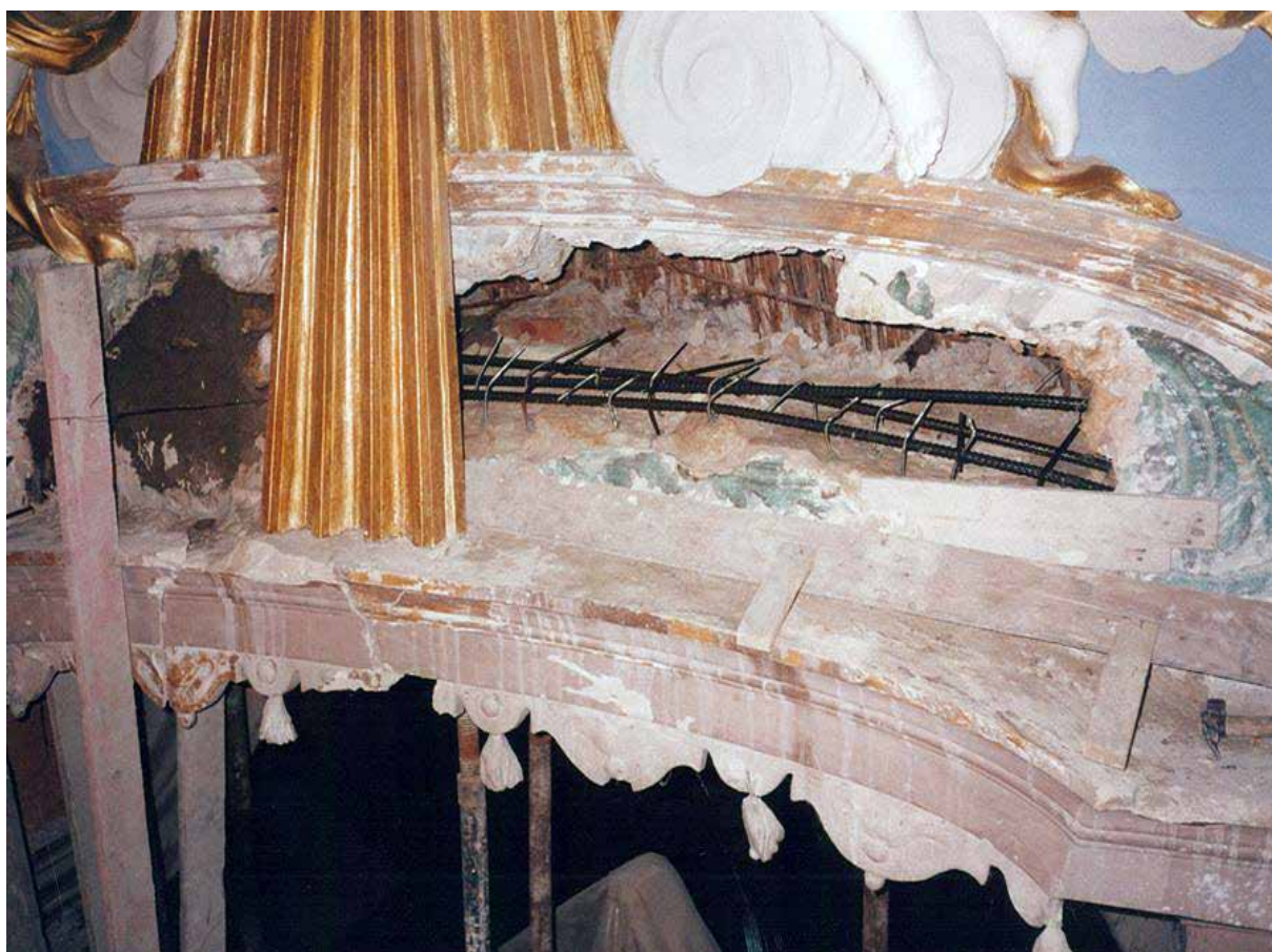
Particolare del Consolidamento delle volte
