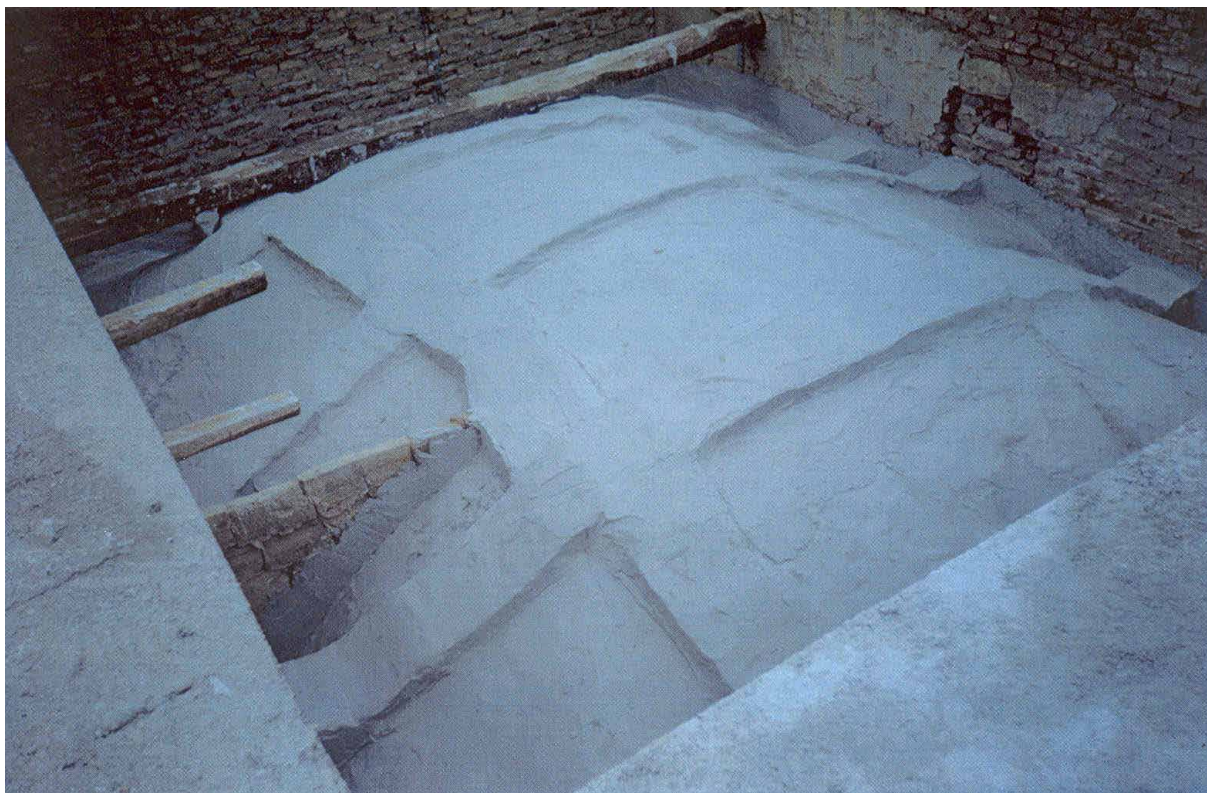
Volte dopo il consolidamento
