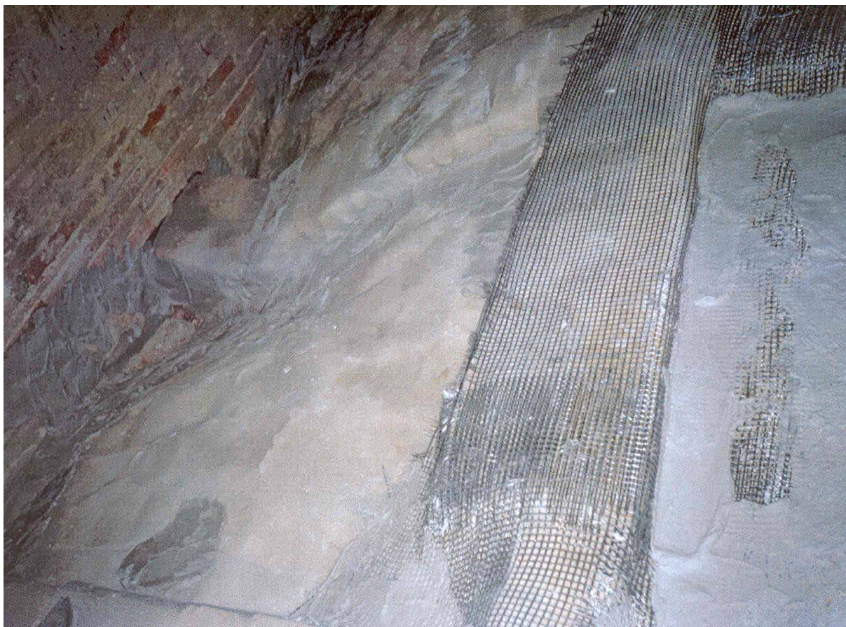
Restauro volte - 3° fase lavorativa: rinforzo delle volte con rete in fibre di vetro
