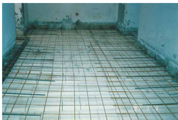
A sx posa del ferro per il getto in CLS - A dx verifica con strumento della percentuale di umidità nei locali
