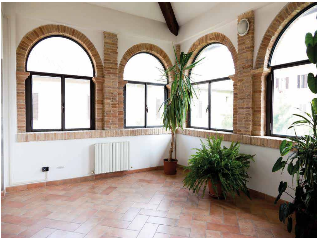
Particolare del locale a lavori ultimati
