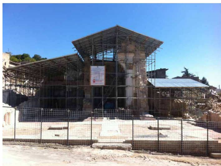
Particolari della copertura e puntellamento in tubi e giunti e chiesa di San Gregorio dopo il puntellamento
