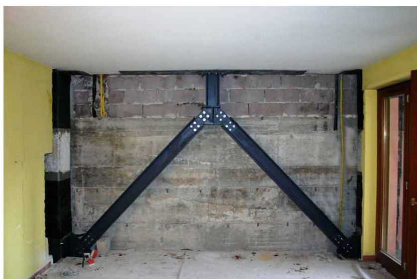
Controventatura in acciaio
