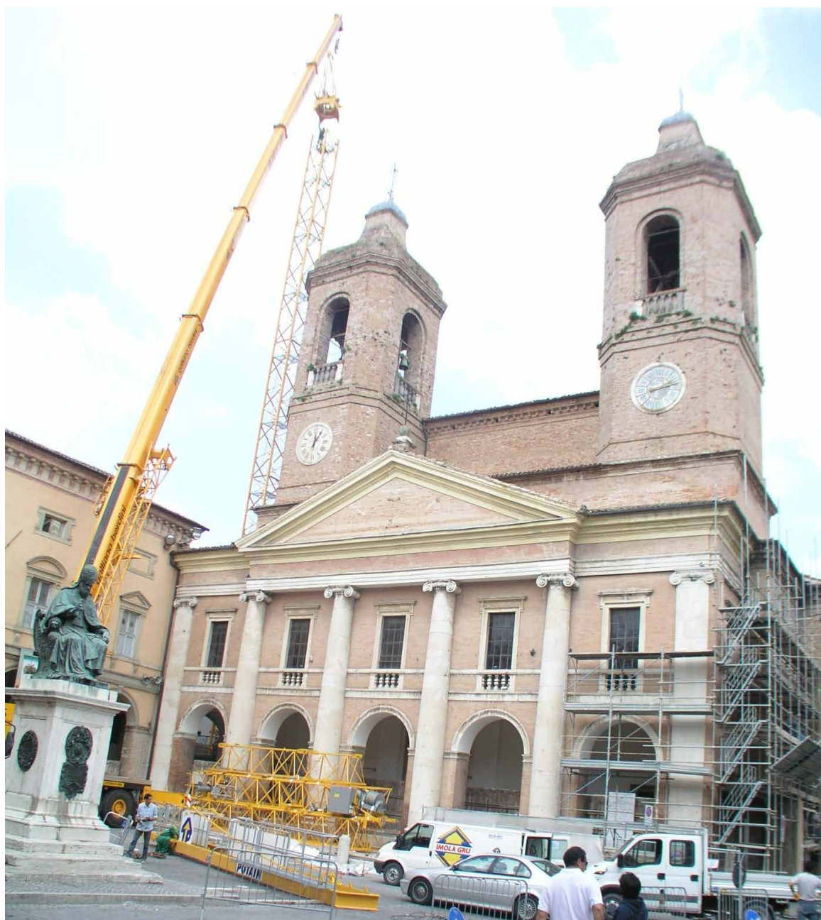
Cattedrale di Camerino prima del restauro -Allestimento cantiere
