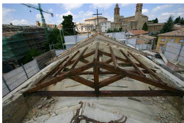
Particolare sostituzione dell'orditura principale della copertura
