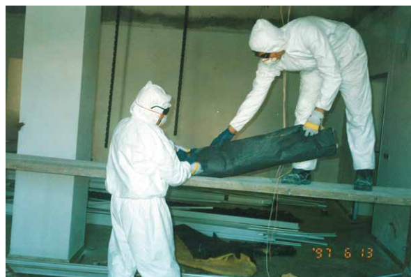
A sx locali prima del restauro - A dx rimozione di pannelli di lana di roccia
