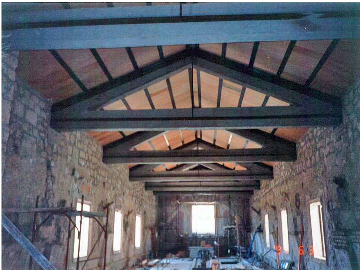
Particolare delle travi in CLS della copertura
