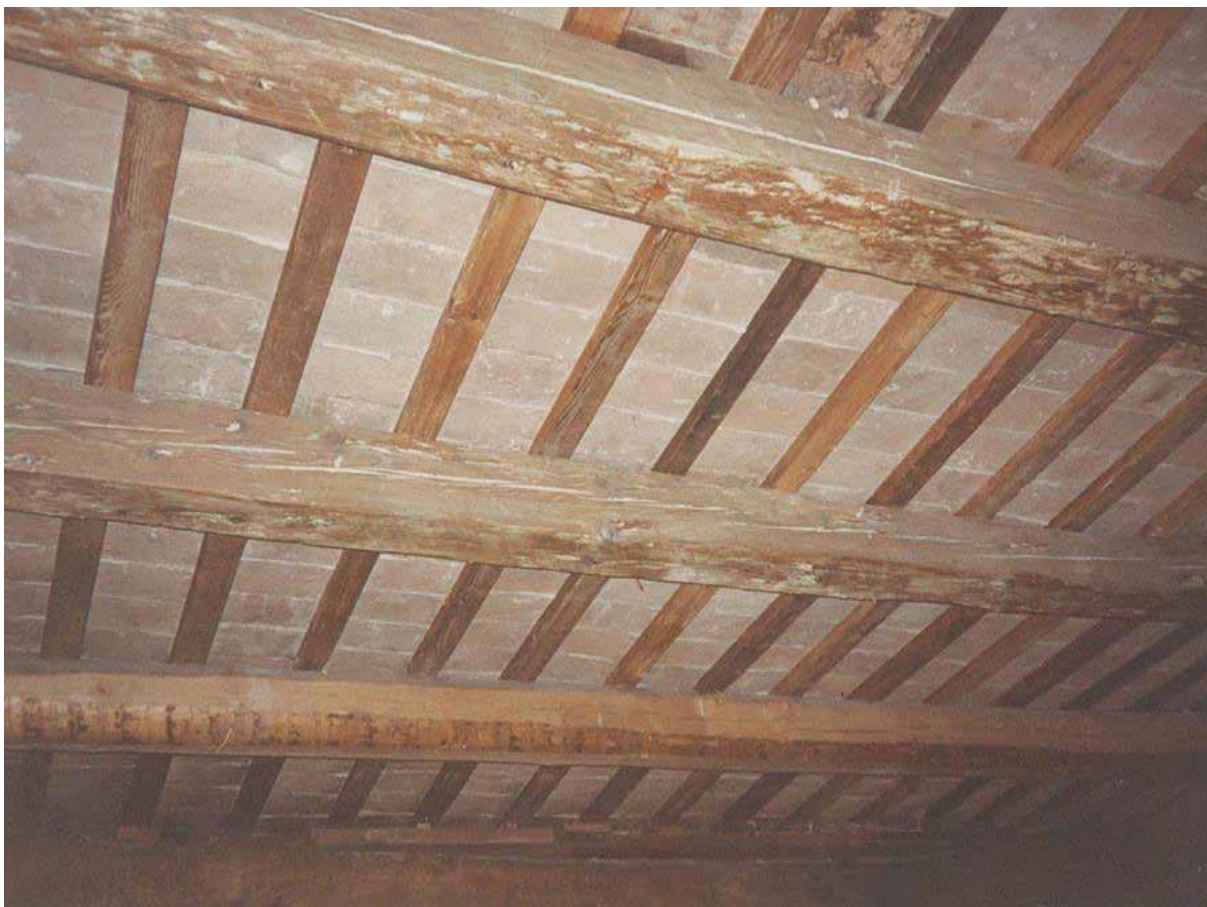
L'intradosso della copertura ultimata
