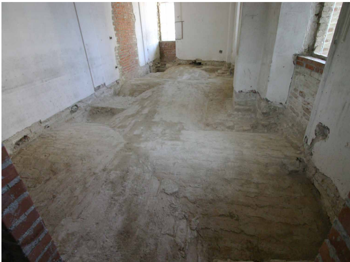
Consolidamento della volta - 1° fase lavorativa: svuotamento con accurata pulizia dell'estradosso della volta
