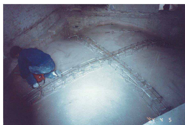
Particolari del consolidamento delle volte portanti
