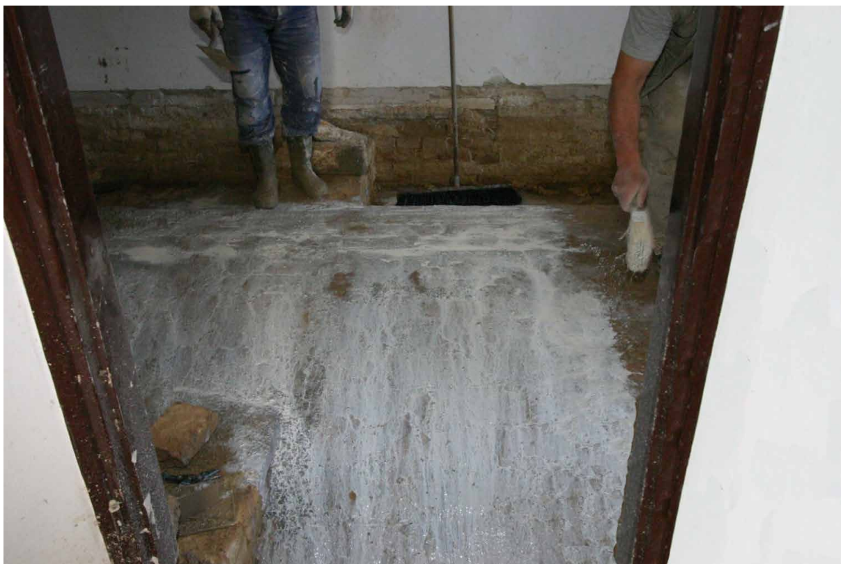
Consolidamento della volta - 2° fase lavorativa: posa di uno strato di aggrappante per assicurare la perfetta adesione
