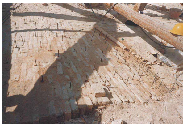
Particolare del consolidamento delle volte del sottotetto
