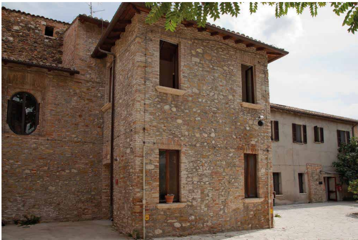
Particolare del locale a lavori ultimati
