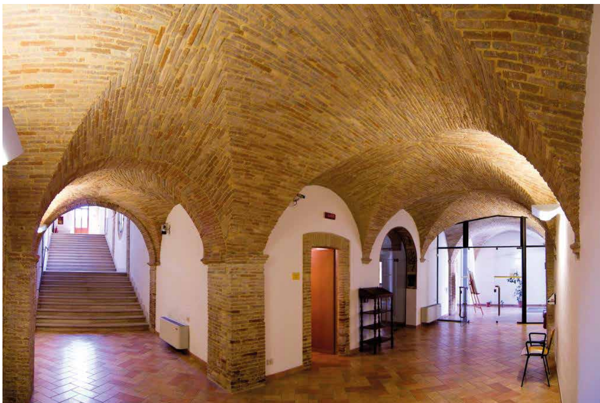
Volte dopo il restauro
