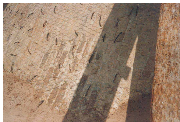
Particolare del consolidamento delle volte del sottotetto
