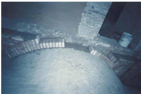
Particolare del consolidamento delle volte portanti con rinforzo con rete elettrosaldata
