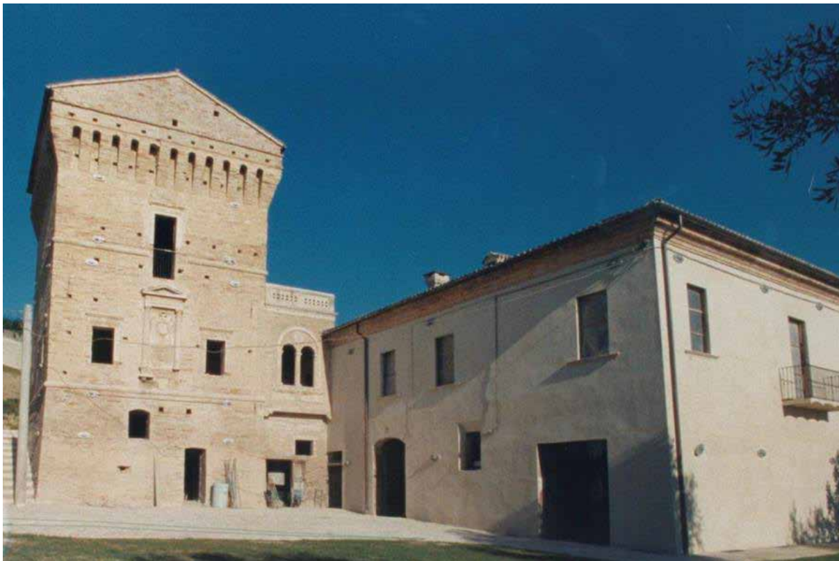
Torre Carlo V prima del restauro
