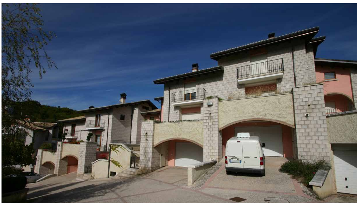
Vista esterna del “Borgo Degli Elfi”
