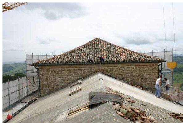
A sx veduta dall'alto dell'Istituto - A dx scomposizione del manto di copertura
