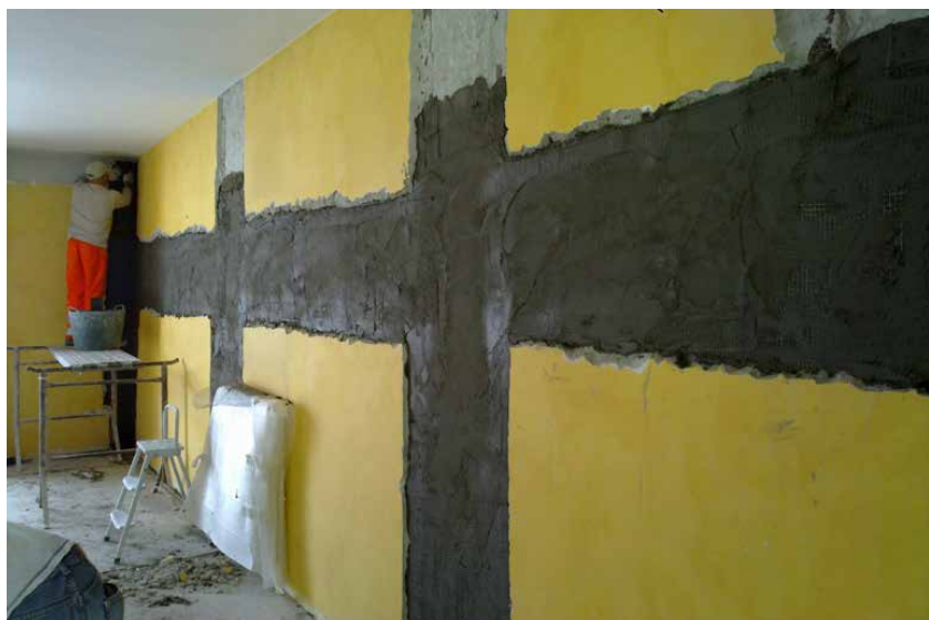
Rinforzo strutturale con fibra di vetro
