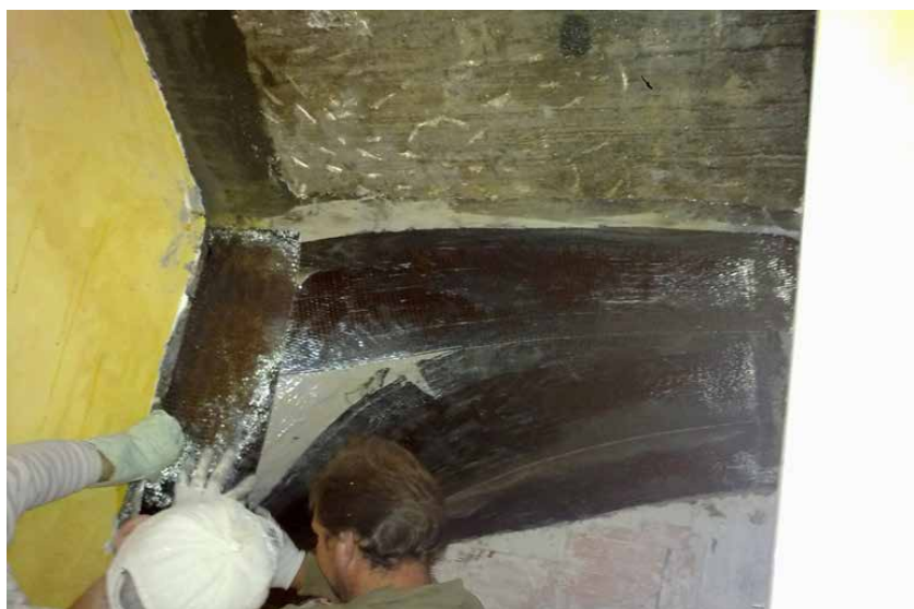
Rinforzo strutturale con fibra in carbonio
