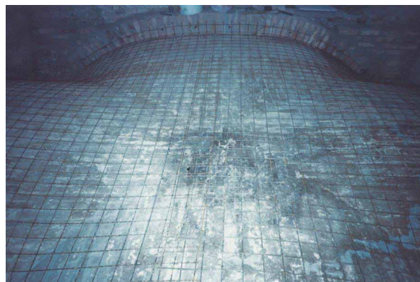
Particolare del consolidamento delle volte portanti con rinforzo con rete elettrosaldata
