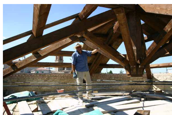
Particolare sostituzione dell'orditura principale della copertura
