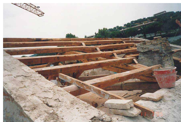
Smontaggio totale della copertura
