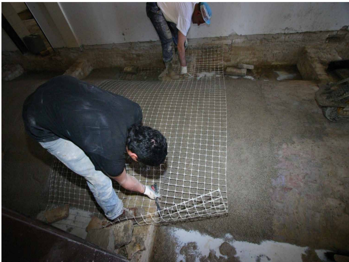
Consolidamento della volta - 3° fase lavorativa: posa di rete biorientata in polipropilene
