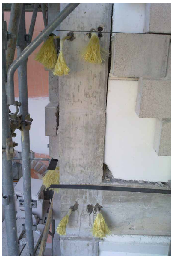
Ripristino cortina esterna con fiocchi in fibre aramidiche e resine epossidiche con l'applicazione di lamine in carbonio
