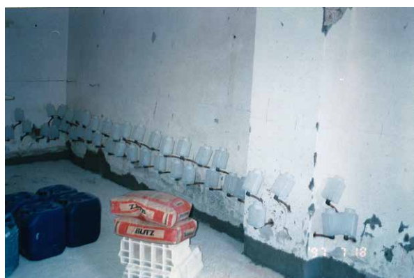
A sx esecuzione dello sbarramento chimico contro la risalita capillare dell'umidità A dx riempimento dei fori con malta speciale deumidificante
