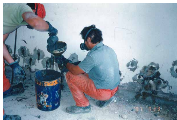
A sx esecuzione dello sbarramento chimico contro la risalita capillare dell'umidità A dx riempimento dei fori con malta speciale deumidificante
