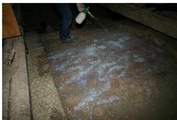
A sx particolare di posa di aggrappante per migliorare l'adesione della malta A dx particolare dell'estradosso ultimato dal consolidamento
