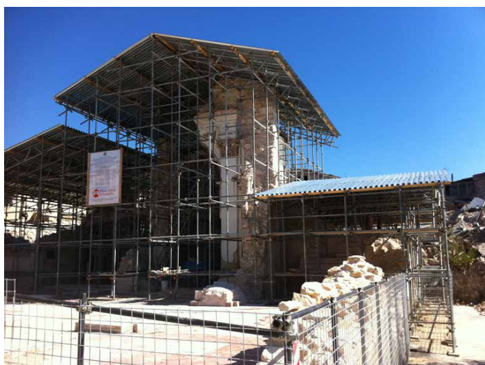
Particolari della copertura e puntellamento in tubi e giunti e chiesa di San Gregorio dopo il puntellamento
