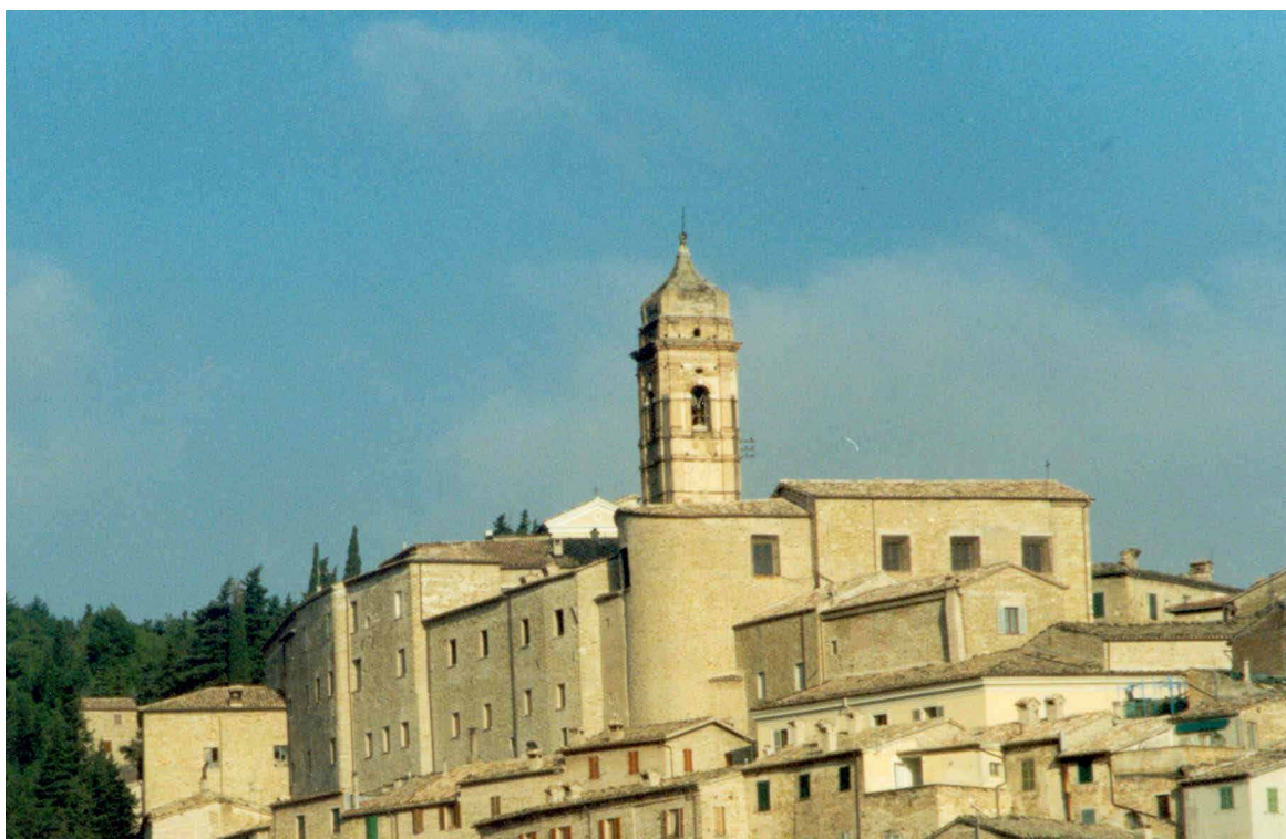
Torre della Chiesa di Santa Lucia prima del restauro
