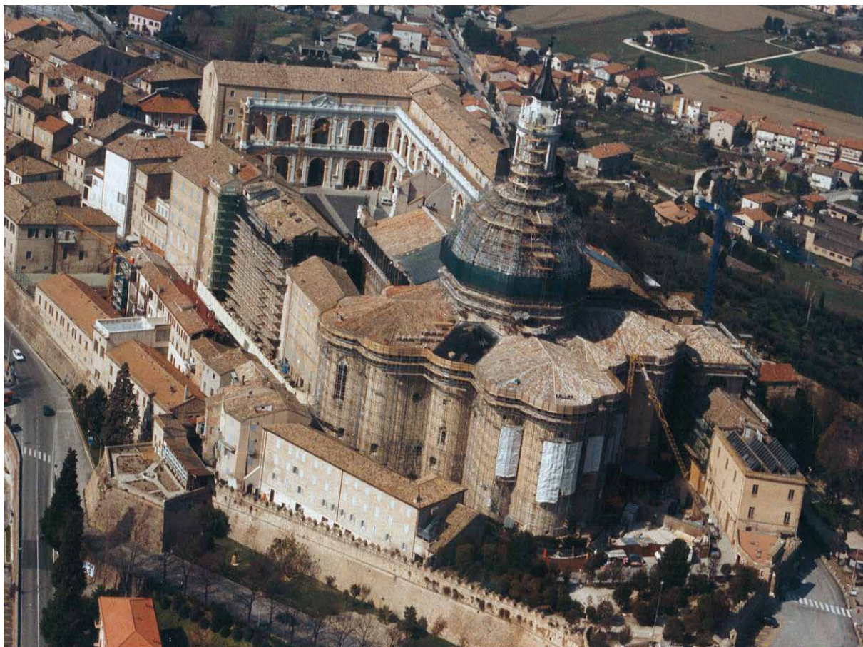
Basilica di Loreto durante le fasi lavorative
