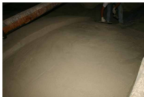
A sx particolare di posa di aggrappante per migliorare l'adesione della malta A dx particolare dell'estradosso ultimato dal consolidamento
