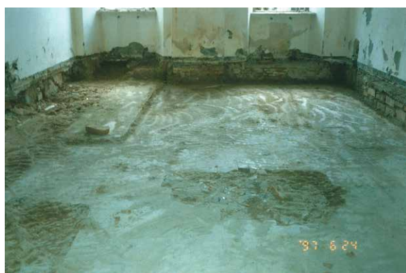
A sx demolizione del pavimento per eseguire il drenaggio - A dx posa di telo di nylon e tavelloni per il drenaggio
