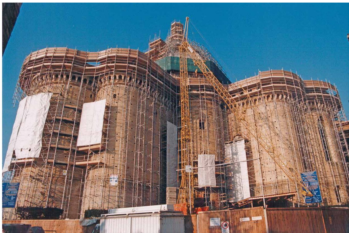
Basilica di Loreto durante le fasi lavorative
