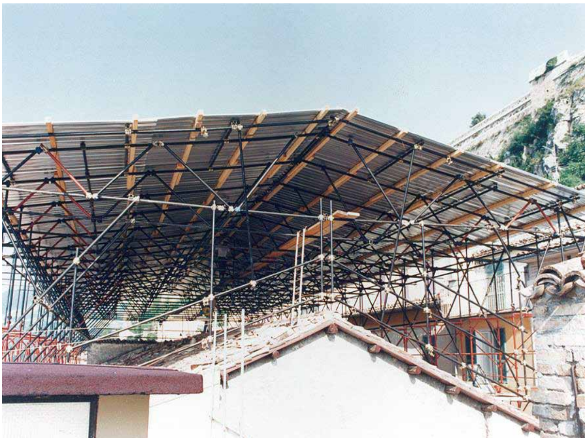
Copertura provvisoria in tubi e giunti
