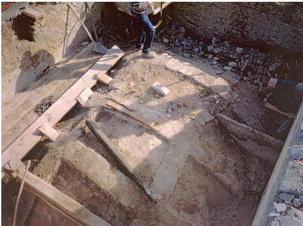
Restauro volte - 1° fase lavorativa: svuotamento dell'estradosso della volta
