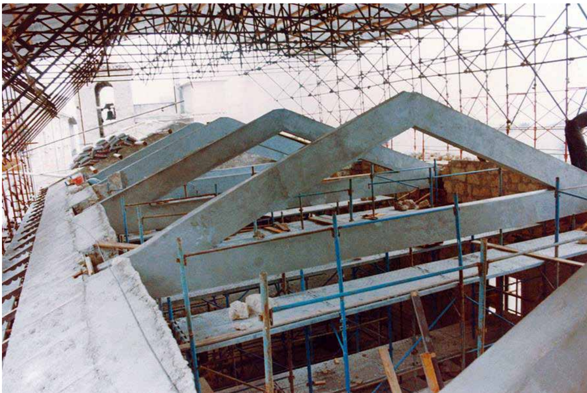
Particolari delle travi in CLS della copertura
