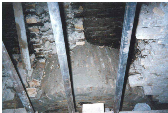
A sx particolare di ricostruzione della volta - A dx particolare della volta ricostruita
