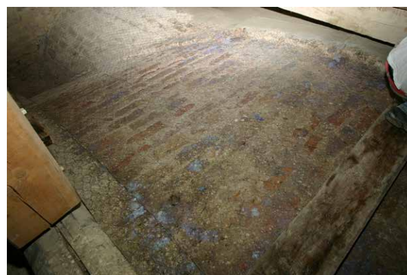
A sx particolare dell'estradosso da consolidare - A dx particolare dell'estradosso con la rete metallica come rinforzo
